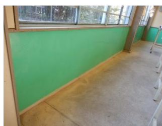
図4. 補修後の教室の壁
