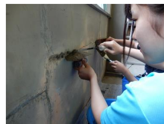
図5. ひび割れの補修
