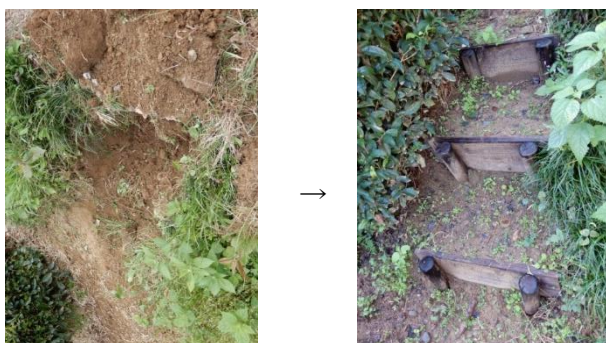
図1. 階段の補修 (左: 補修前 右: 補修後)
